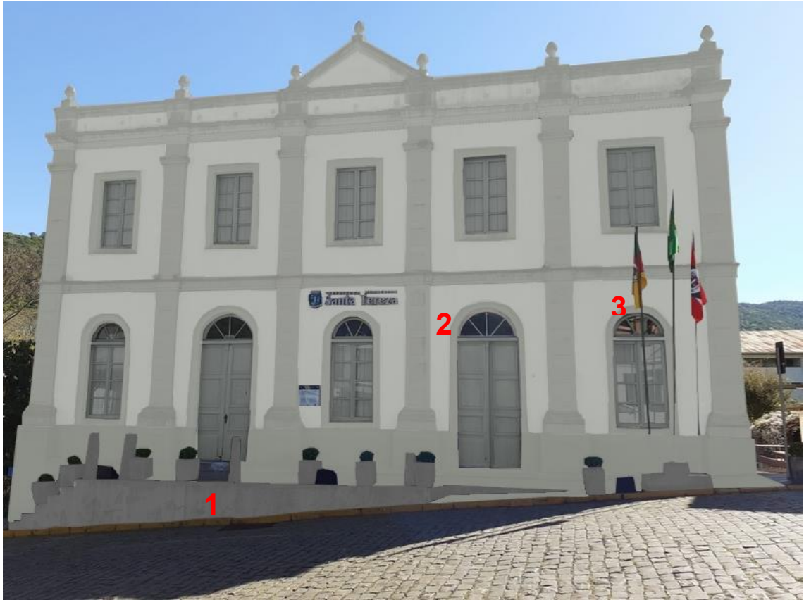
Fig -4 - Fachada frontal leste do Centro Administrativo de Santa Tereza
