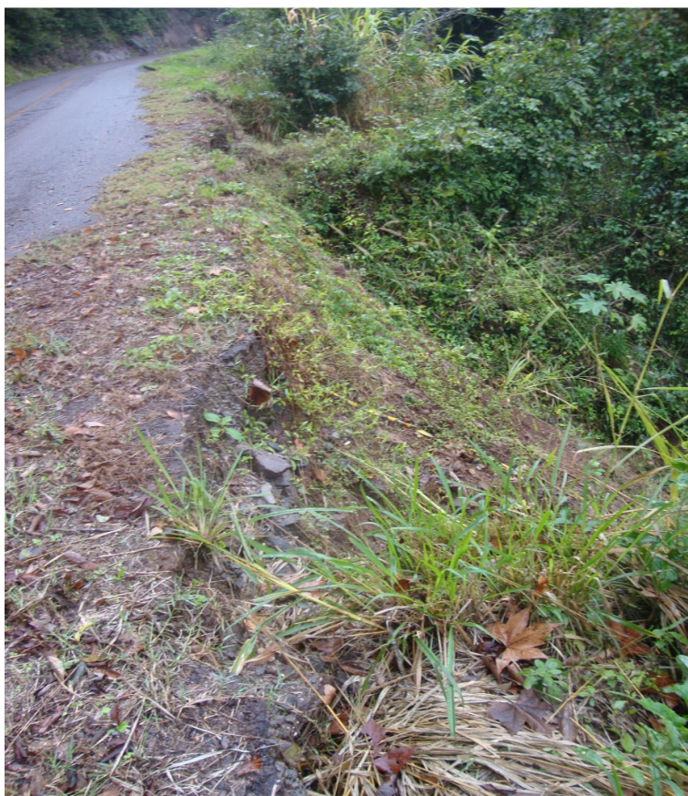
PISTA COMPROMETIDA - RISCO DE DESMORRONAMENTO TAMANHO = 30.00 m.(C)
