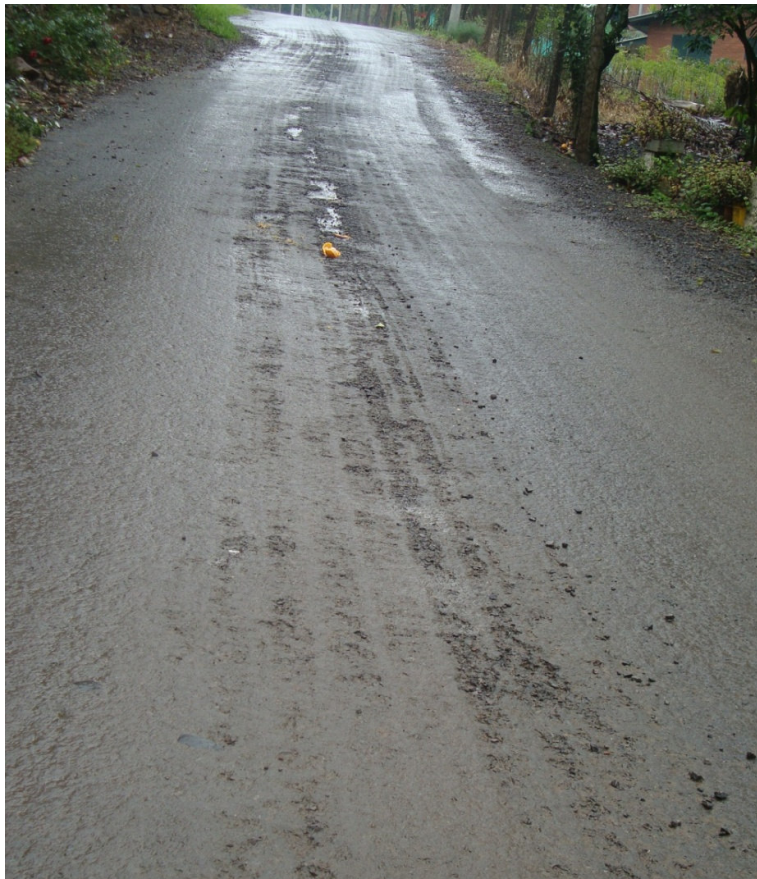
ASFALTO DANIFICADO
