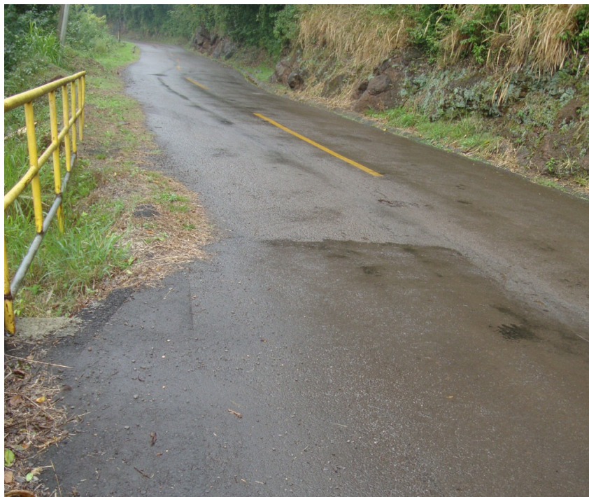
ESTREITAMENTO ACENTUADO DA PISTA E DESNÍVEL TAMANHO = 5.00 m.(L) X 10.00 m.(C)
