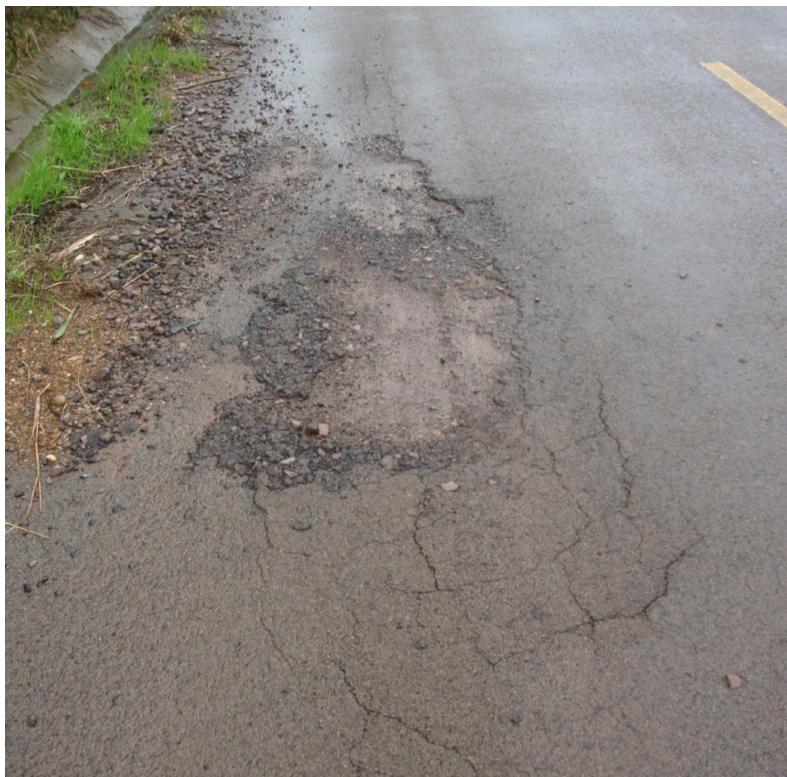
RACHADURAS E BURACO TAMANHO = 2.00 m.(L) X 5.00 m.(C)
