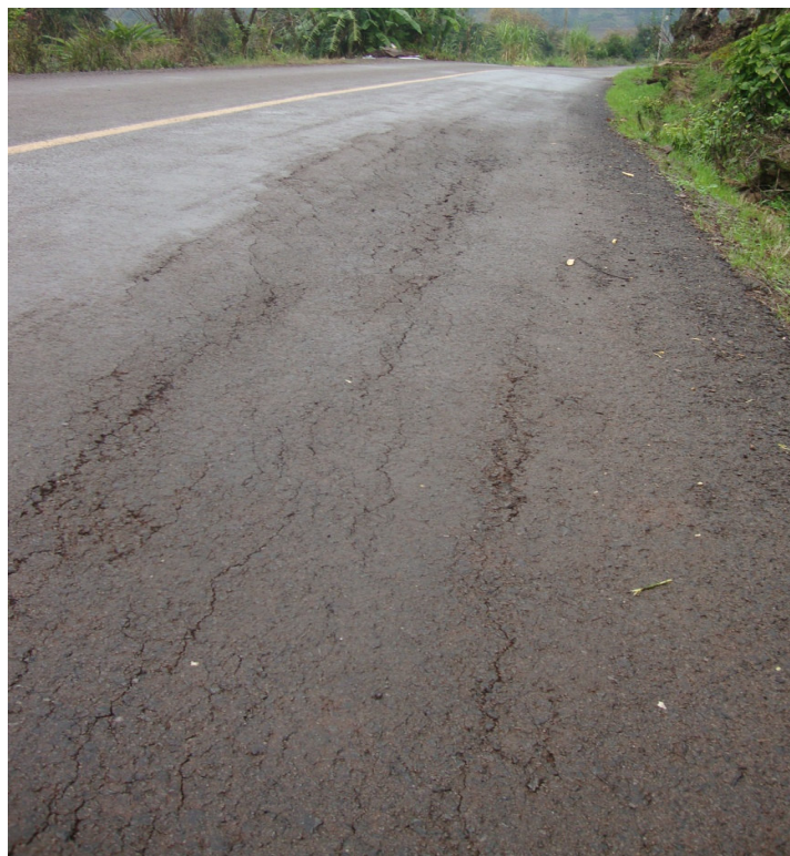
RACHADURAS E DESNÍVEL AO LONGO DA PISTA TAMANHO = 3.00 m.(L) X 15.00 m.(C)
