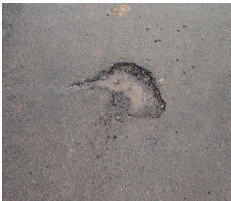
FINAL DO ASFALTO - BURACO TAMANHO = 1.00 m.(L) X 1.00 m.(C)
