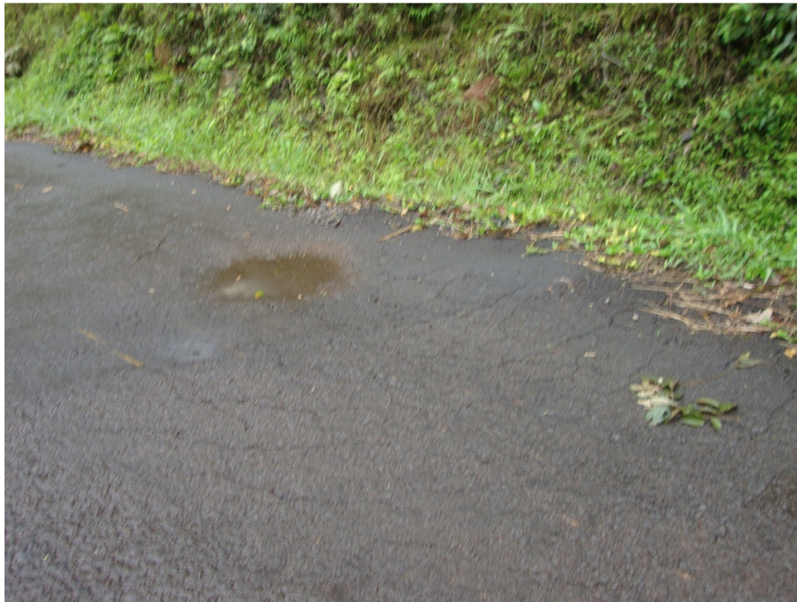
RACHOS E DESNÍVEL AO LONGO DA PISTA - COM MAIS FREQUÊNCIA NAS CURVAS TAMANHO = 2.00 m.(L) X 3.00 m.(C)
