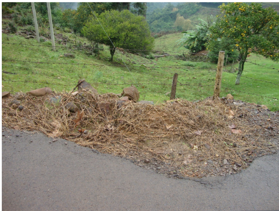
ENCOSTAMENTO DANIFICADO - BURACO TAMANHO = 1.00 m.(L) X 2.00 m.(C)
