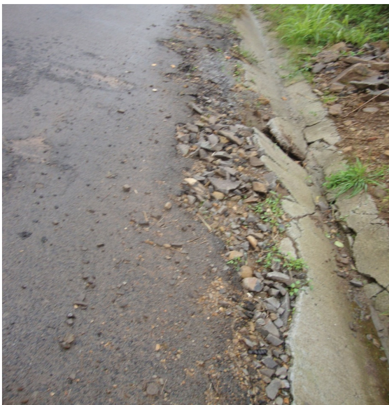
ENCOSTAMENTO DANIFICADO TAMANHO = 1.00 m.(L) X 6.00 m.(C)
