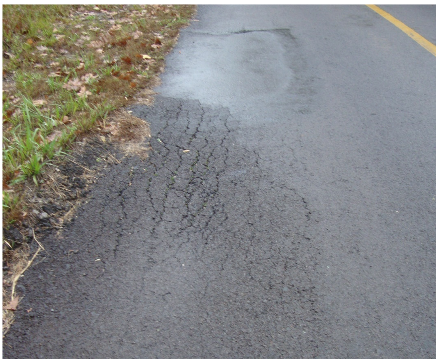
RACHOS E DESNÍVEL AO LONGO DA PISTA - COM MAIS FREQUÊNCIA NAS CURVAS TAMANHO = 2.00 m.(L) X 6.00 m.(C)
