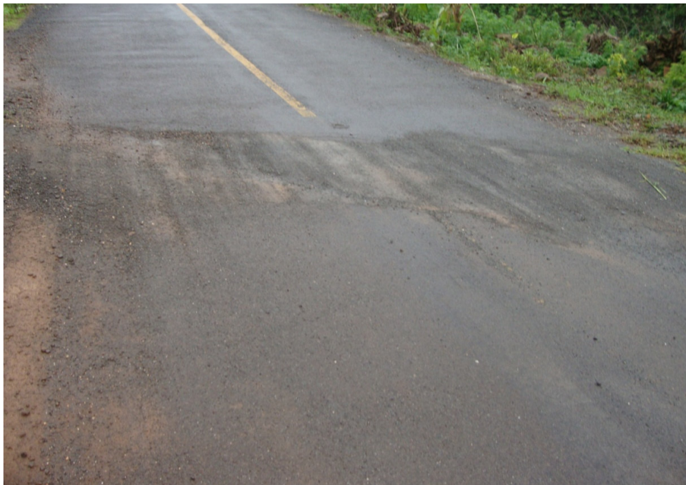
CORTE NO ASFALTO (BOEIROS) - BALDISSERA TAMANHO = 3.00 m.(L) X 6.00 m.(C)
