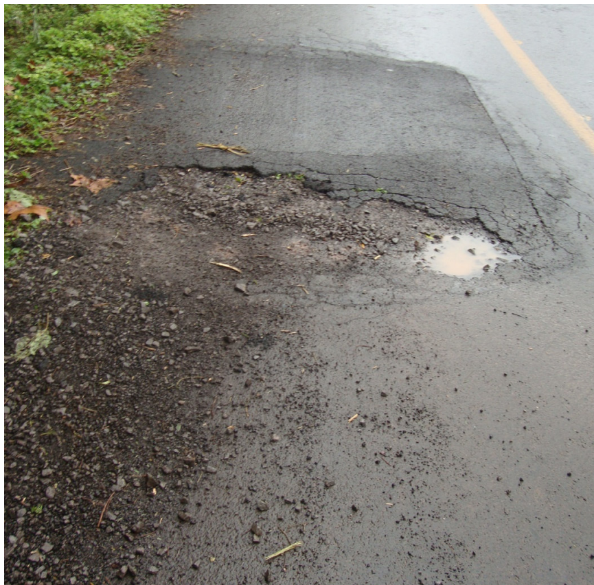
RACHADURAS E BURACO TAMANHO = 3.00 m.(L) X 6.00 m.(C)
