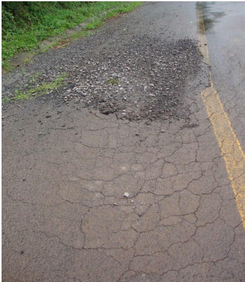
FINAL DO ASFALTO - DESNÍVEL, BURACO E RACHOS TAMANHO = 3.00 m.(L) X 5.00 m.(C)
