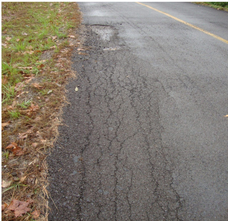
RACHOS E DESNÍVEL AO LONGO DA PISTA – COM MAIS FREQUÊNCIA NAS CURVAS (2) TAMANHO = 2.00 m.(L) X 30.00 m.(C)
