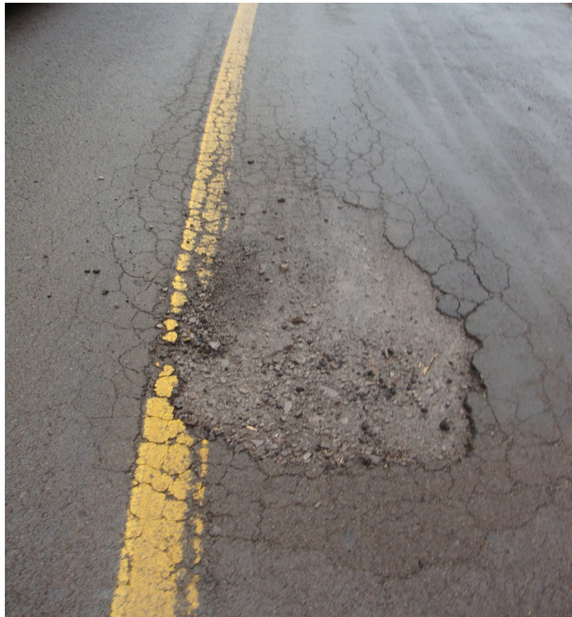
RACHADURAS E BURACO TAMANHO = 3.00 m.(L) X 6.00 m.(C)
