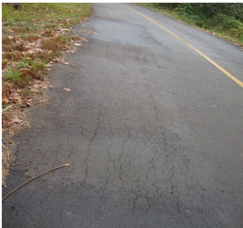
RACHOS E DESNÍVEL AO LONGO DA PISTA – COM MAIS FREQUÊNCIA NAS CURVAS TAMANHO = 2.00 m.(L) X 10.00 m.(C)
