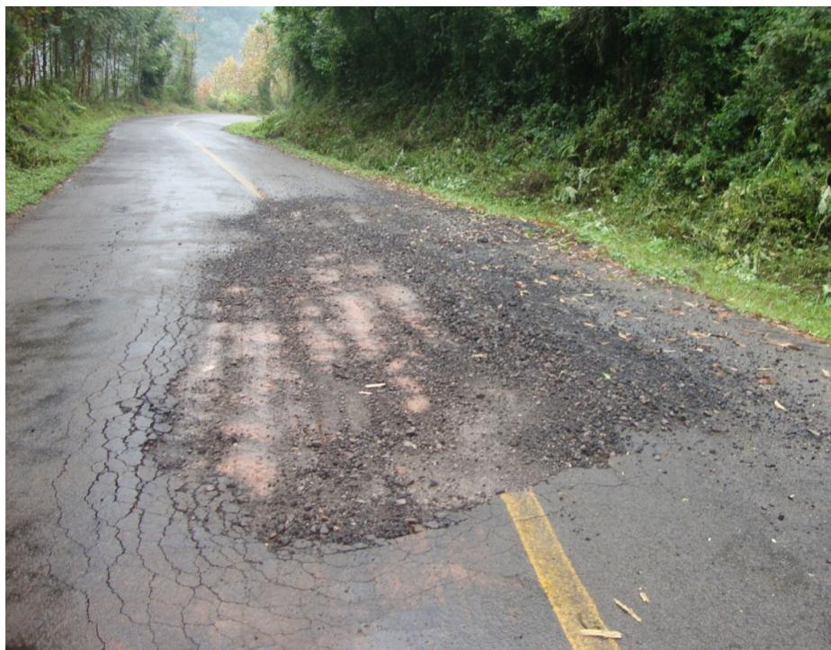
ASFALTO DANIFICADO - BURACO E RACHADURAS TAMANHO = 6.00 m.(L) X 15.00 m.(C)
