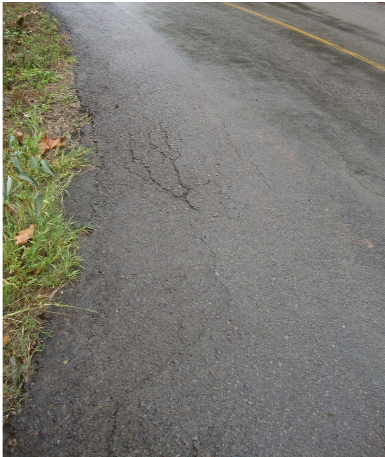
RACHOS AO LONGO DA PISTA – COM MAIS FREQUÊNCIA NAS CURVAS
