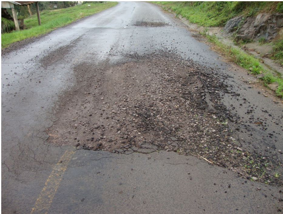
RACHADURAS, BURACO E DESNÍVEL - LAERTE PANIZZI (2) TAMANHO = 6.00 m.(L) X 20.00 m.(C)
