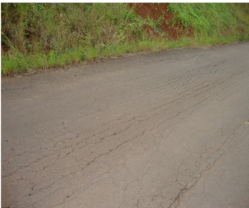
DESNÍVEL ACENTUADO E RACHADURAS - TAMANHO = 4.00 m.(L) X 18.00 m.(C)
