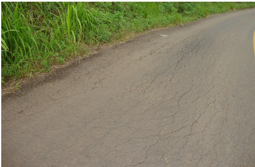
DESNÍVEL ACENTUADO E RACHADURAS – TAMANHO = 4.00 m.(L) X 8.00 m.(C)
