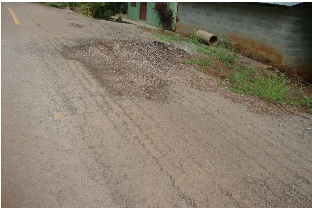
FONTANA - BURACO E RACHADURAS - TAMANHO = 5.00 m.(L) X 10.00 m.(C)
