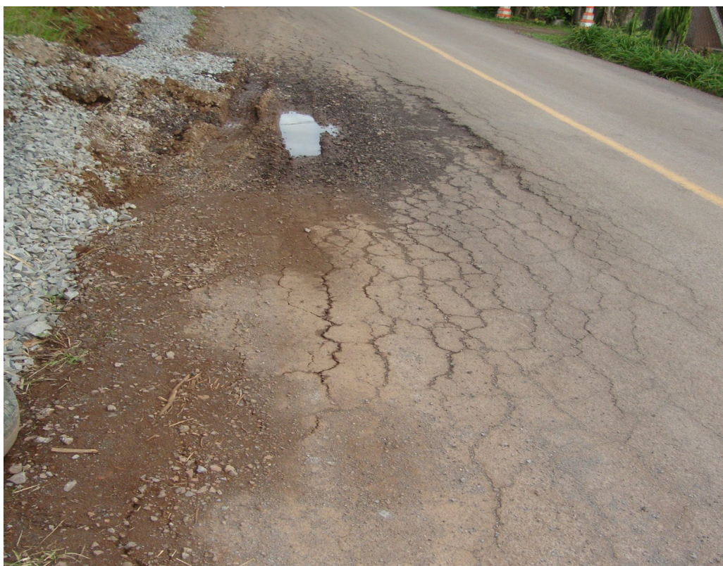
TRENTIN - BURACO E RACHADURAS - TAMANHO = 4.00 m.(L) X 30.00 m.(C)
