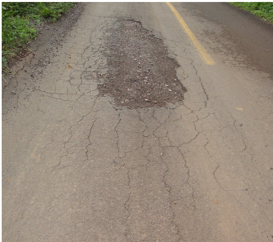
BURACO, DESNÍVEL E RACHADURAS- TAMANHO = 4.00 m.(L) X 20.00 m.(C)
