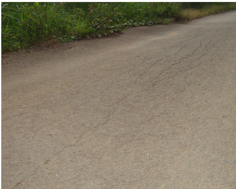
DESNÍVEL ACENTUADO E RACHADURAS- TAMANHO = 3.00 m.(L) X 10.00 m.(C)
