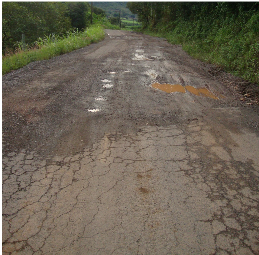
PROXIMO AO TREVO DE ACESSO AS LINHAS JOSÉ JULIO E LINHA BENTO-TODO DANIFICADO, BURACOS E RACHADURAS - TAMANHO = 6.50 m.(L) X 55.00 m.(C)
