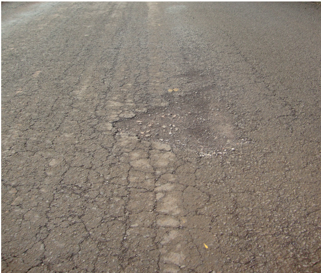
RACHADURAS POR TODA PISTA E BURACOS
