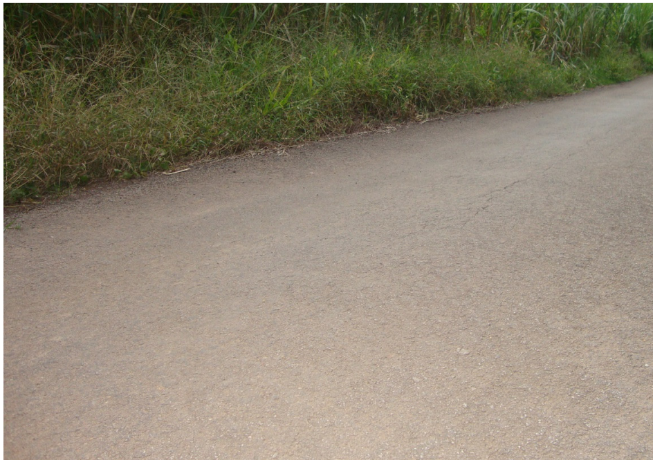
DESNÍVEL ACENTUADO E RACHADURAS – TAMANHO = 2.00 m.(L) X 8.00 m.(C)
