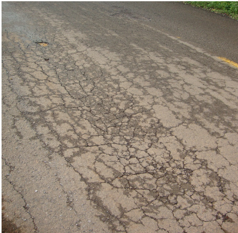
RACHADURAS POR TODA PISTA
