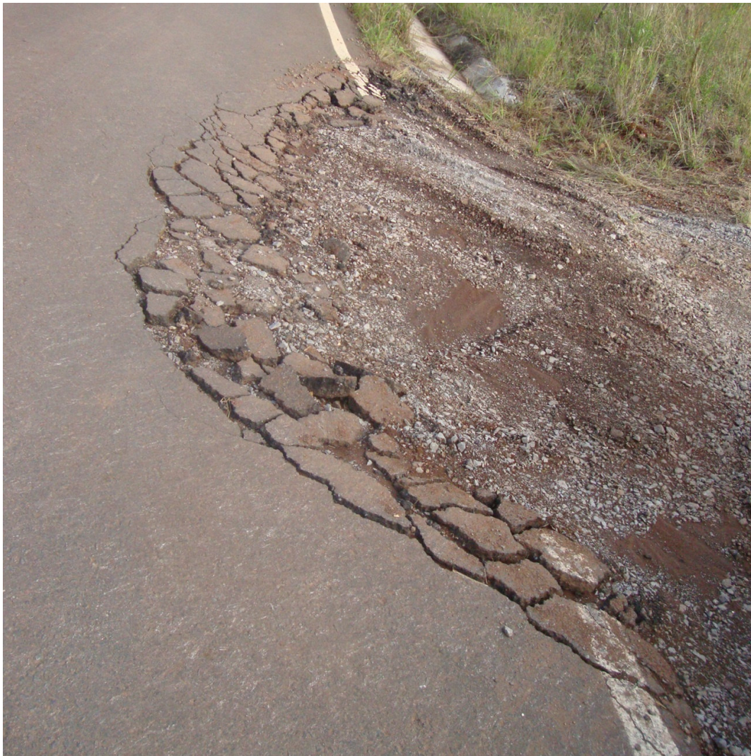
PISTA DANIFICADA (1) - TAMANHO = 2.00 m.(L) X 6.00 m.(C)
