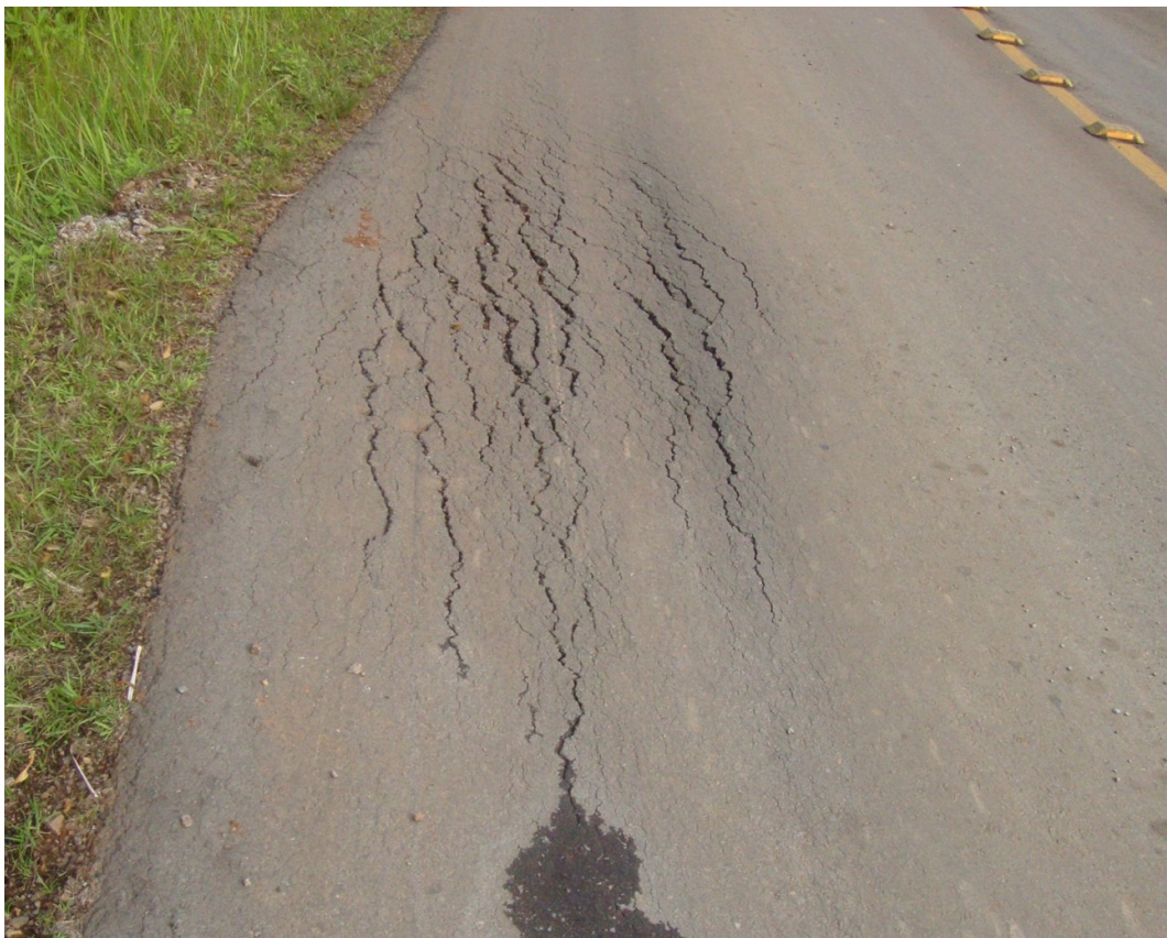
DESNÍVEL E RACHADURAS - TAMANHO = 1.50 m.(L) X 6.00 m.(C)
