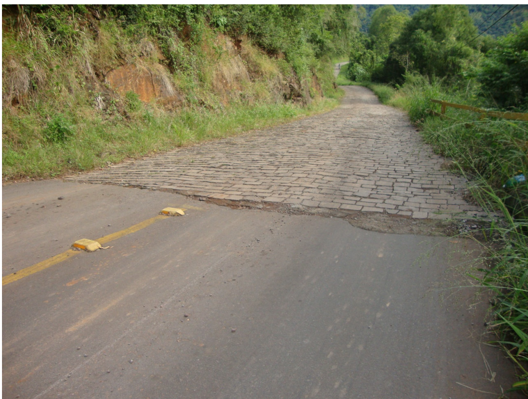
FINAL DO CALÇAMENTO DANIFICADO - BURACO TAMANHO = 5.00 m.(L) X 1.00 m.(C)
