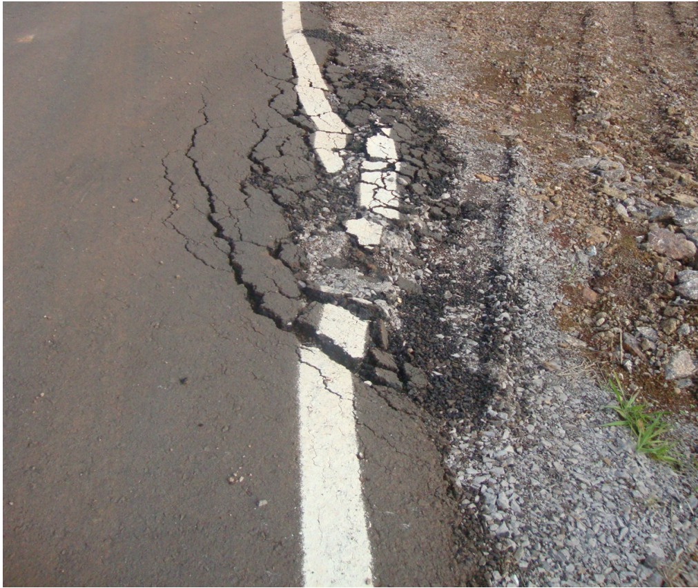
PISTA DANIFICADA (3) - TAMANHO = 1.00 m.(L) X 3.00 m.(C)
