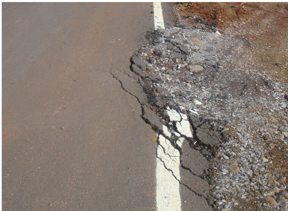
PISTA DANIFICADA (2) - TAMANHO = 1.00 m.(L) X 3.00 m.(C)
