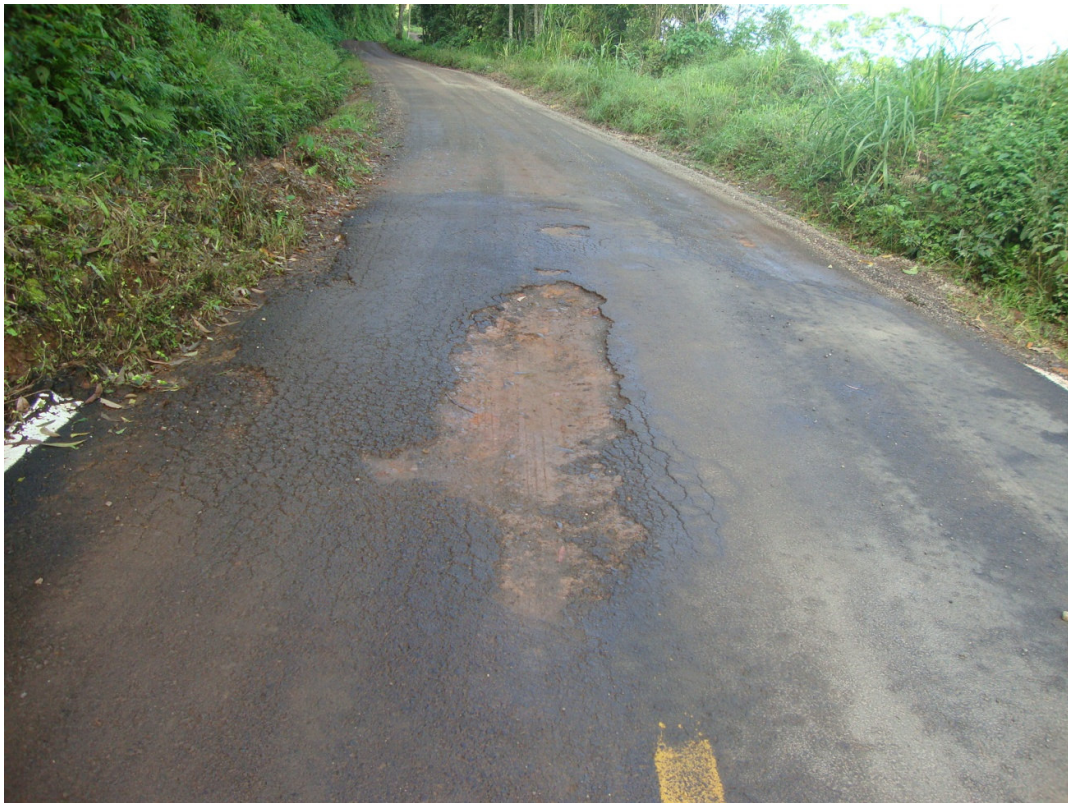
FINAL DO TRECHO - RACHOS E BURACO - TAMANHO = 2.50 m.(L) X 4.00 m.(C)
