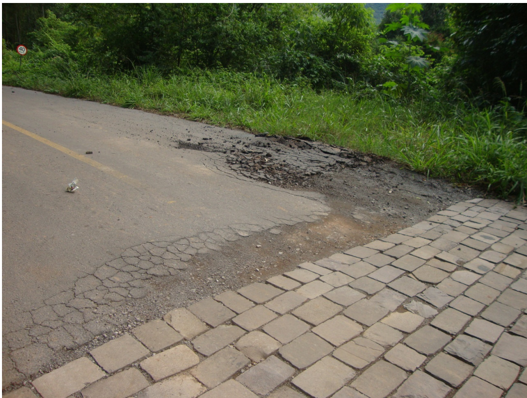
INICIO DO CALÇAMENTO DANIFICADO - BURACO, RACHOS E DESNÍVEL TAMANHO = 5.00 m.(L) X 4.00 m.(C)
