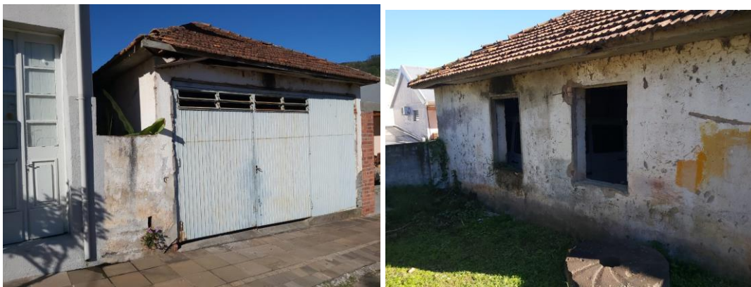
Imagem 1-2- Fachada Norte e Fachada sul
