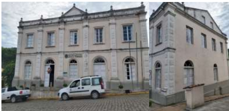
Figura 2 – Fachada leste e norte do prédio
