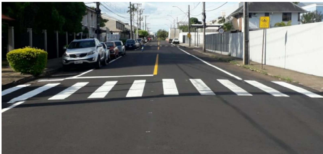
Figura 10 – Faixa de Travessia de Pedestres – Tipo Zebrada
