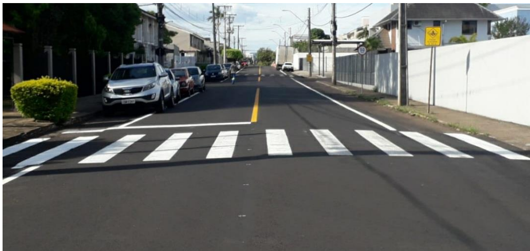
Figura 10 – Faixa de Travessia de Pedestres – Tipo Zebrada
